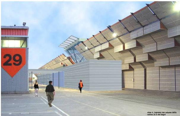
L'edificio di collegamento proposto, della larghezza di m. 15 e della lunghezza di circa m. 90, sarà realizzato con strutture d'acciaio saldate ed imbullonate in opera, aventi le medesime caratteristiche estetiche e di conformazione strutturale dei padiglioni adiacenti, in modo tale da creare un organismo razionale e di sicuro impatto visivo ottimamente inserito nel nucleo storico del quartiere fieristico.
