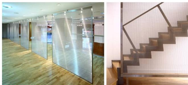
E' prevista la realizzazione di moduli costruttivi per il sistema espositivo, caratterizzati dall'uso delle reti metalliche in acciaio inox, pensati apposta per rispondere alle esigenze di una struttura come l'Urban Center: grande flessibilità, facilità di rimozione e messa in opera, anche da parte di personale non specializzato.
